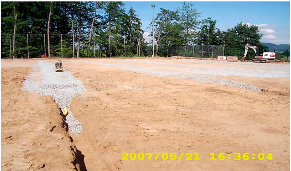
Zunächst mussten überall Drainagen eingezogen werden
